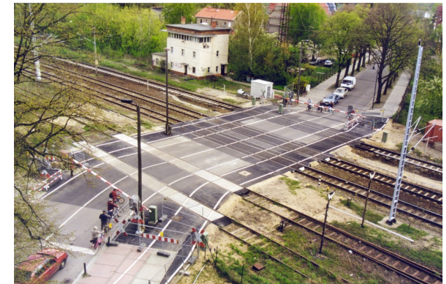
2001 wurde der Bahnübergang Freiheitstraße komplett neu gebaut.
